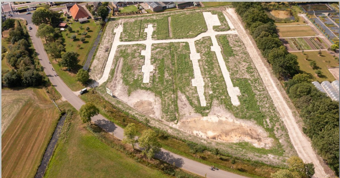
Luchtfoto: grondwerk en egalisatie gereed
