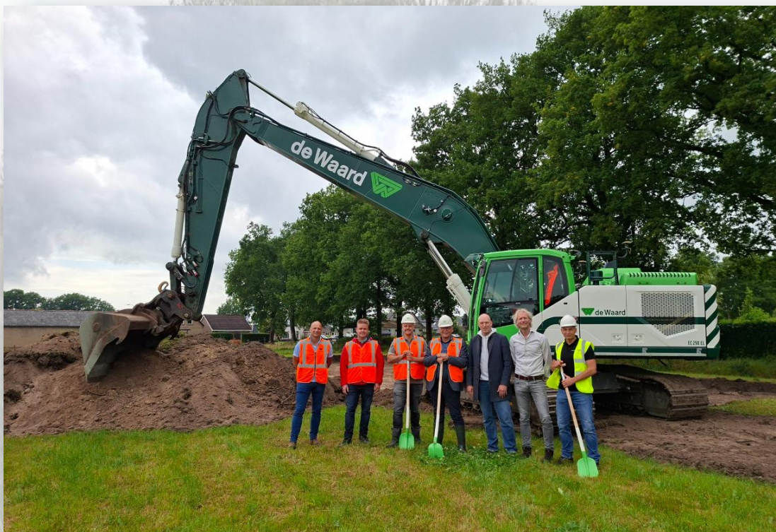
Aanvangshandeling bouwrijp maken op 26 juni jl.
